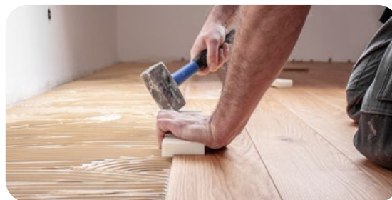
Handwerker mit einem neuen Werkzeug
